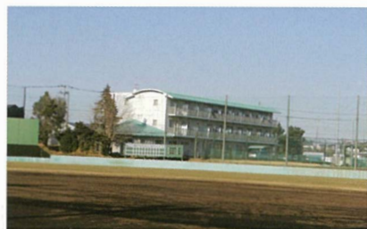
白井グラウンド (昭和39年完成) より貫行寮を望む
