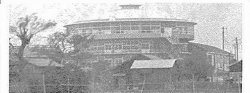
本校初の鉄筋校舎「東館」完成
