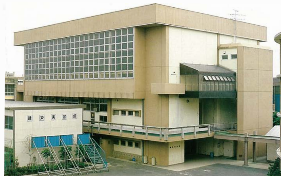
校庭から見た総合体育館
