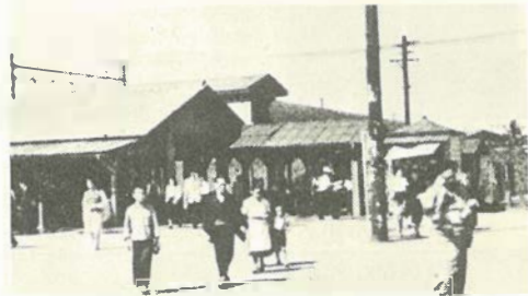
昭和3年ごろの新小岩駅。建物や利用客の服装に時代がしのばれる
