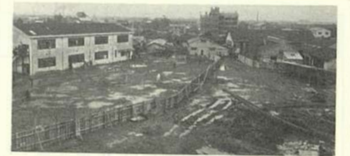
「西館」工事に着工
