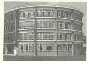
完成した「西館」
