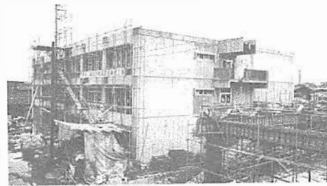
建築中の機械科総合実習館
