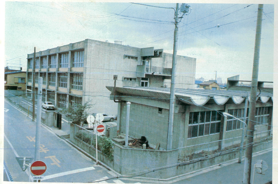
機械科総合実習館
